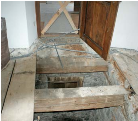
Bauliche Sanierung des Gebäudes
